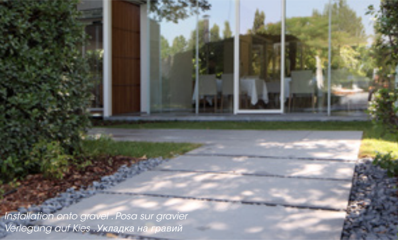
POSA SU GHIAIA
